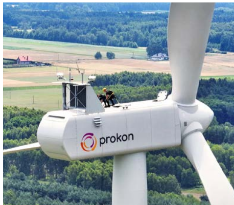
Arbeiten an einer Anlage in Rusiec II.
